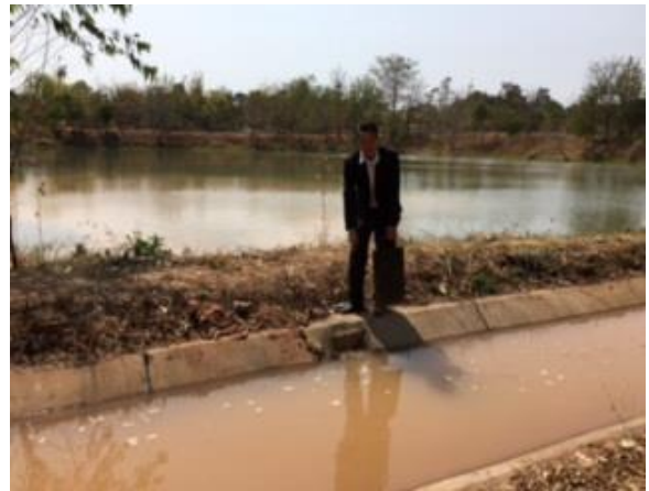
คลองส่งน้ำตาดคอนกรีต
